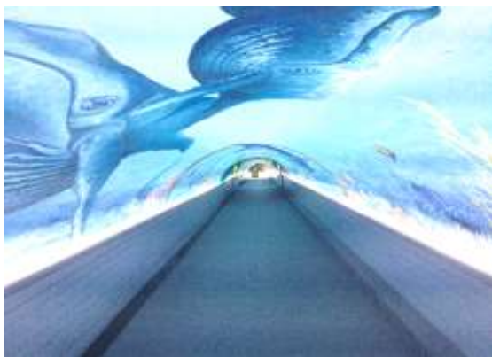
Il tunnel sotto la stazione ferroviaria di Cannes La Bocca
