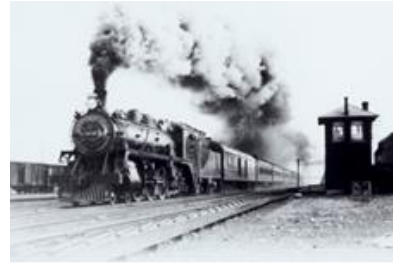
La locomotive à vapeur
