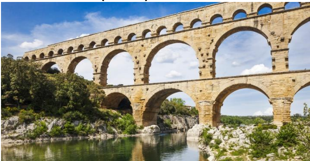
Le Pont du Gard (France)
